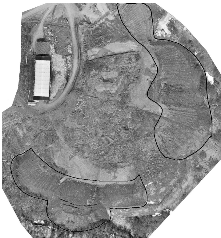
Рисунок 1.11: Ортофотоплан участков, занятых под складирование снега на территории полигона ТБО г. Корсаков, 24.04.2018 г.
